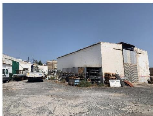
Imagen exterior de la nave aislada
