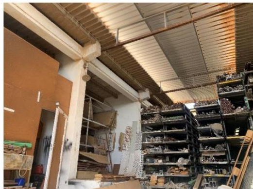
Imagen interior de la nave aislada
